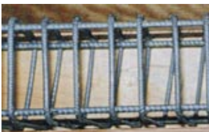
Strzemiona w postaci ciągłej spirali.
