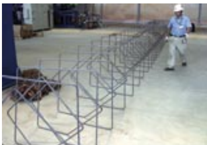
Strzemiona tworzące ciągłą spiralę.
