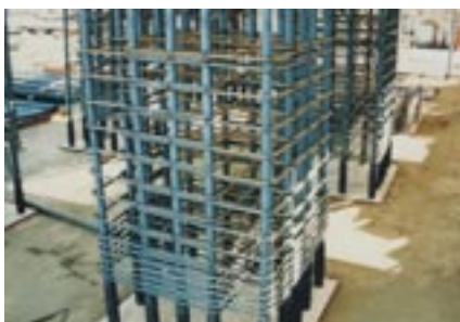
Strzemiona tworzące ciągłą spiralę.
